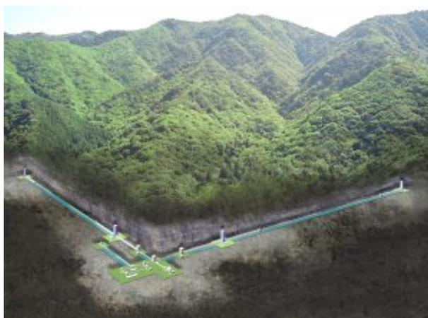
図 1.2: KAGRA の俯瞰図。KAGRA が L 字型になっている、山の中(地下)に建設されていることが分かる。画像提供：東京大学宇宙線研究所 重力波観測研究施設 [5]
