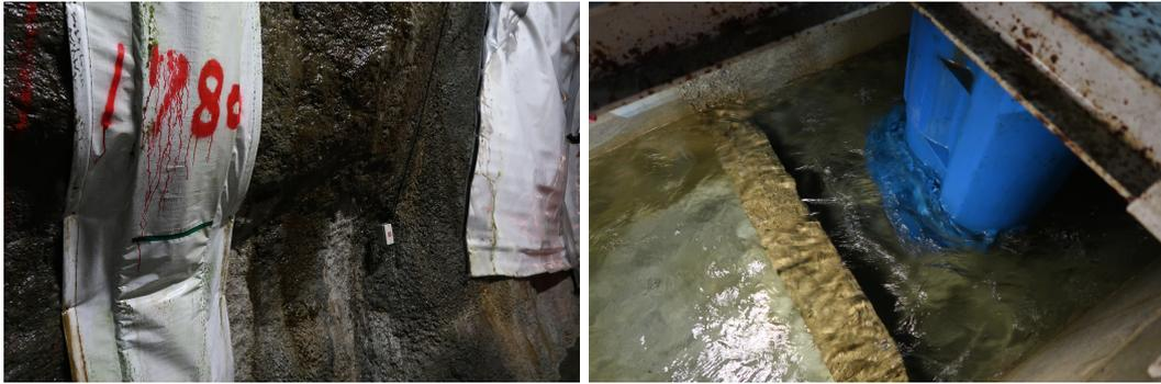
図 2.2: KAGRA 内部で地下水が染み出す様子
