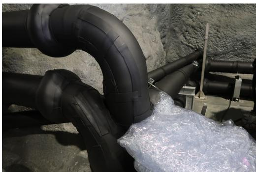
図 2.5: Y-end に向かう強制排水管の様子。Y アームに沿ってパイプが設置されている。
