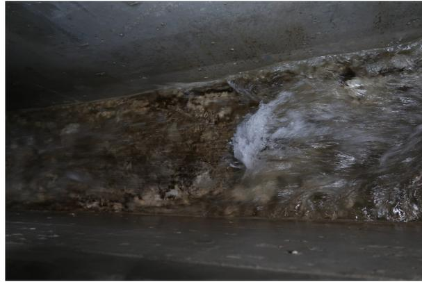
図 3.2: KAGRA 内の水路における跳水の観察。Y-end の奥にある水路、Y アームに沿ったパイプを流れている水の下流である。この水路の断面は直方体になっている。水路中央にある白波が跳水と考えられる。この写真では左側 (上流) が射流になっており、右側 (下流) が常流になっていると考えられる。この写真では判別しにくいですが、跳水手前までの射流領域は水深が浅く、跳水部分で水位が上がり、常流部分では水深が深くなっていることが分かる。これは射流、常流の定義にも矛盾しない。
