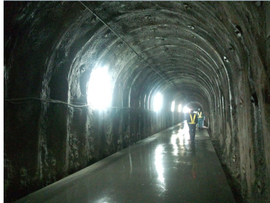
図 23 神岡鉱山トンネル (2014 年 10 月撮影)
